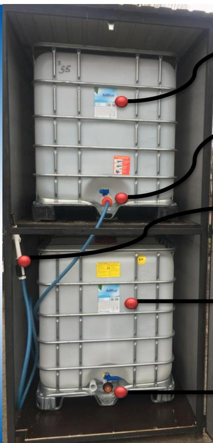
Верхній куб з якого розливається рідина за рахунок сили власної тяжкості та установки точки зливу вище ніж бак авто або каністра, розлив здійснюється без підключення насоса за принципом «самоплив».
